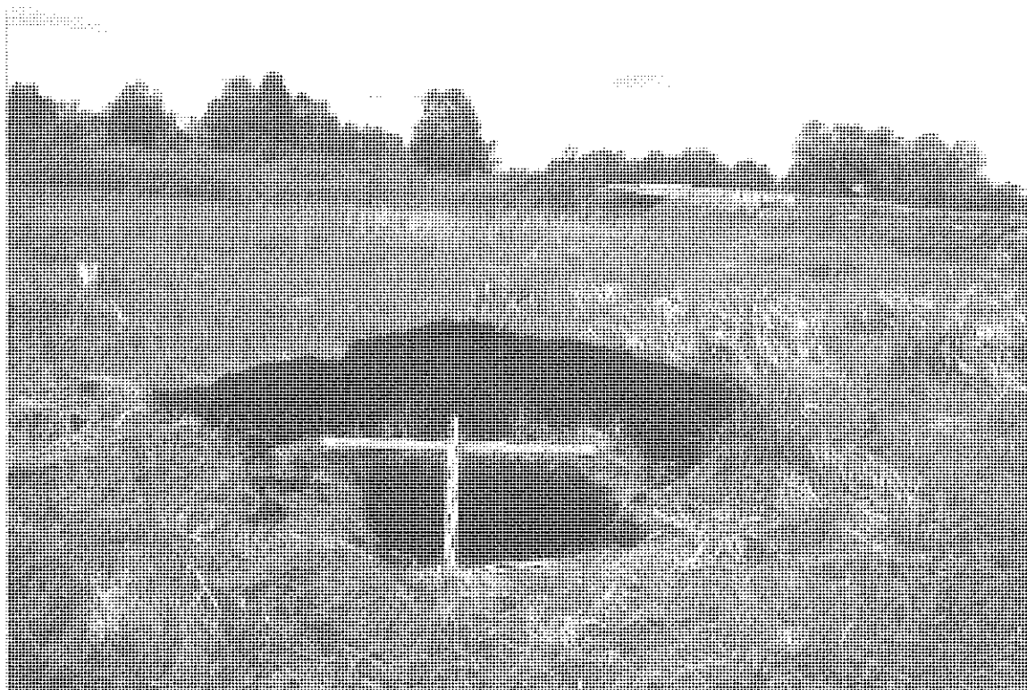
Фото 12. Газопровод высокого давления до объекта курортного субкластера «Белокуриха -2» и туристского субкластера «Сибирское подворье». Правый берег р. Березовка. Шурф 3 Вид В-3.
