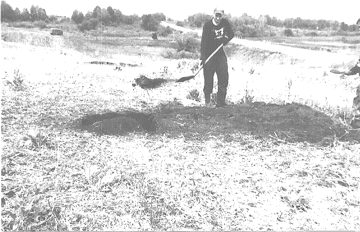
Фото 9. Газопровод высокого давления до объекта курортного субкластера «Белокуриха -2» и туристского субкластера «Сибирское подворье». Рекультивация шурфа 1. На втором плане- закопан шурф 2 Вид В-З
