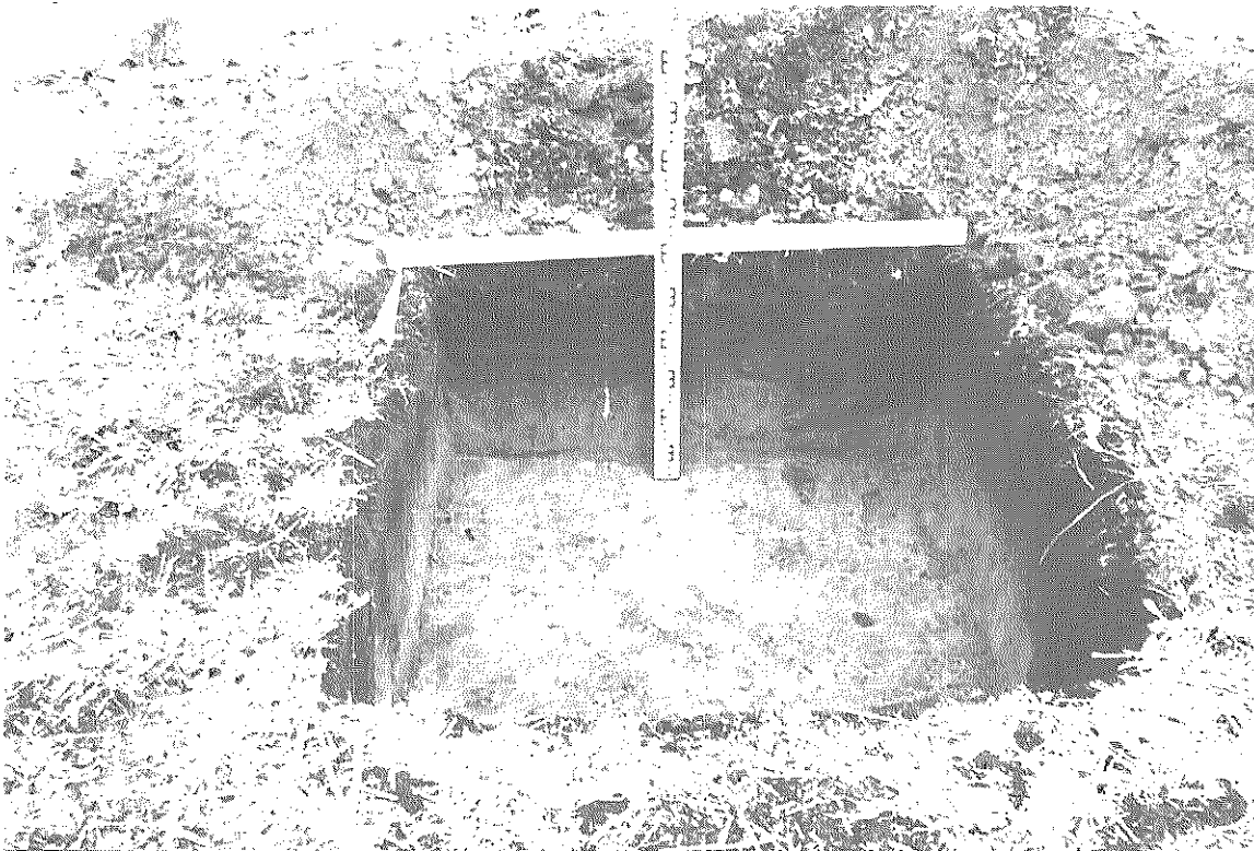
Фото 10. Газопровод высокого давления до объекта курортного субкластера «Белокуриха -2» и туристского субкластера «Сибирское подворье». Шурф 2. Северная стенка. Вид Ю-С.
